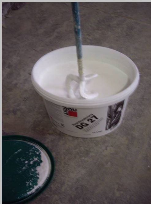
Step 1 Mix primer with a whisk
