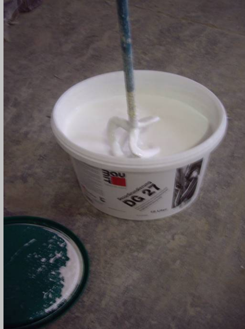
Step 1 Mix primer with a whisk
